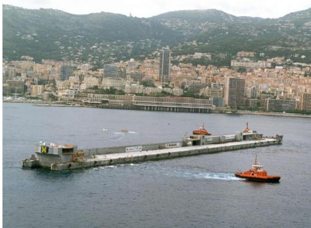
*Manœuvre de rotation et mise en place de la digue à son arrivée à Monaco*
