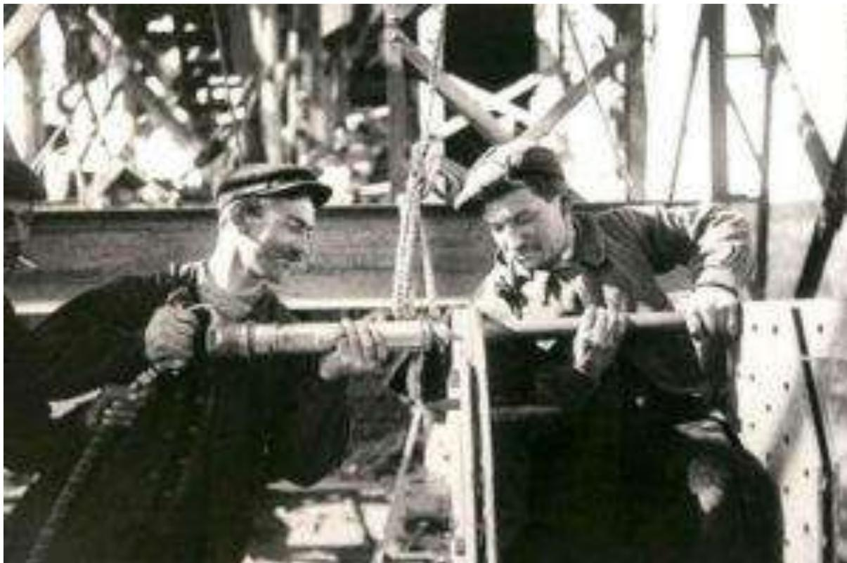
*Ouvriers réalisant le rivetage avec un marteau pneumatique et une bouterolle et un tas*
