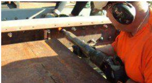
*Les rivets sont chauffés sur place à plus 1100°C*
