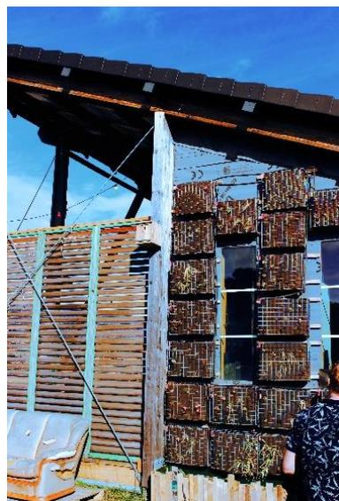
Un système de phyto-épurations recycle l'eau pour la clarifier. Le principe est simple plusieurs couches de substrats se superposent en fonction de leur granulométrie afin d'obtenir une eau claire. Des plantes comme le papyrus permettent d'absorber l'humidité. Enfin, un système rotatif sur le principe d'un mur végétal utilisant les eaux grises est présent sur une façade.
